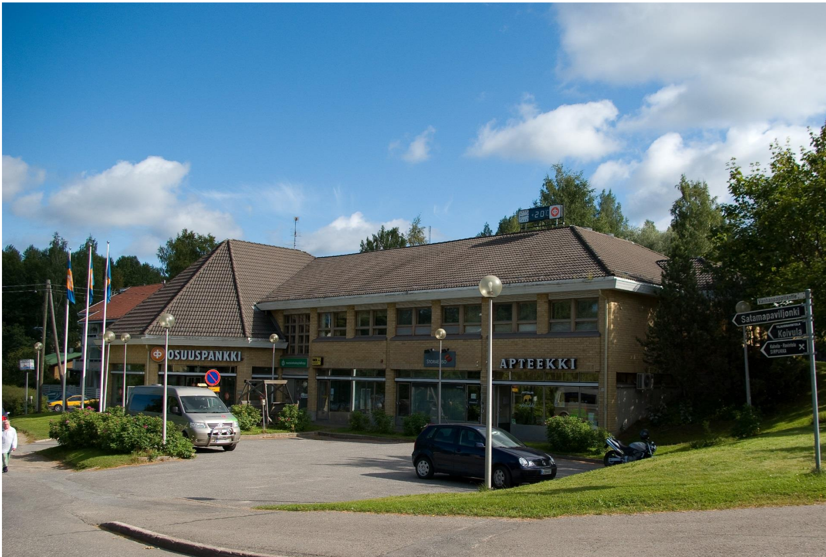
Vanhanpappilantien alkuun 1980-luvun alkupuolella valmistui liike- ja asuinkiinteistö. Kuva vuodelta 2009. Kuva: Kari Valjakka
